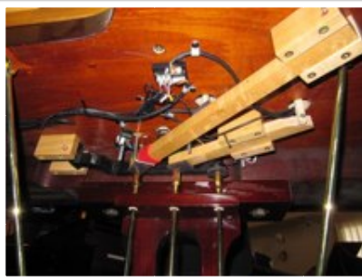
タナ板裏側の取付け例です。
