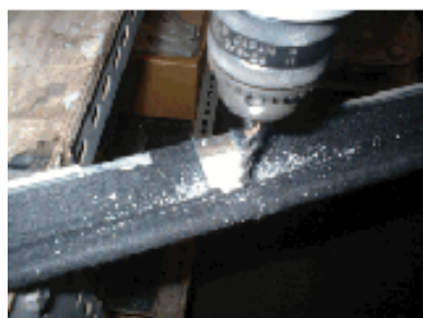
先に切り取る範囲の縦に鉄ノコで切り込みを入れた後に根元はドリルで加工
