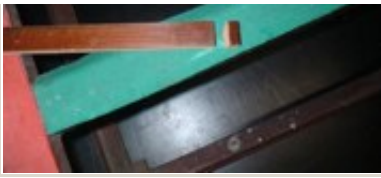
下前のサイドの部材の上部を少し切り取りました。
